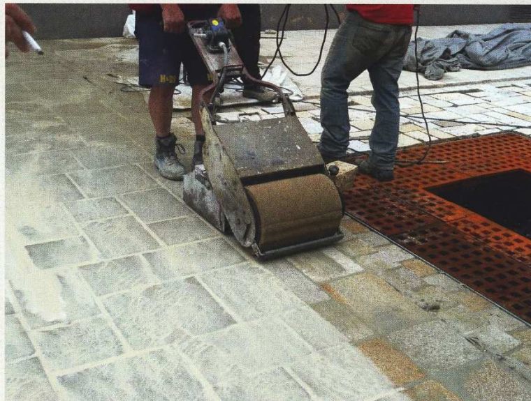
Bild 4: Reinigung einer gebundenen Pflasterdecke mit der Schwammputzmaschine
