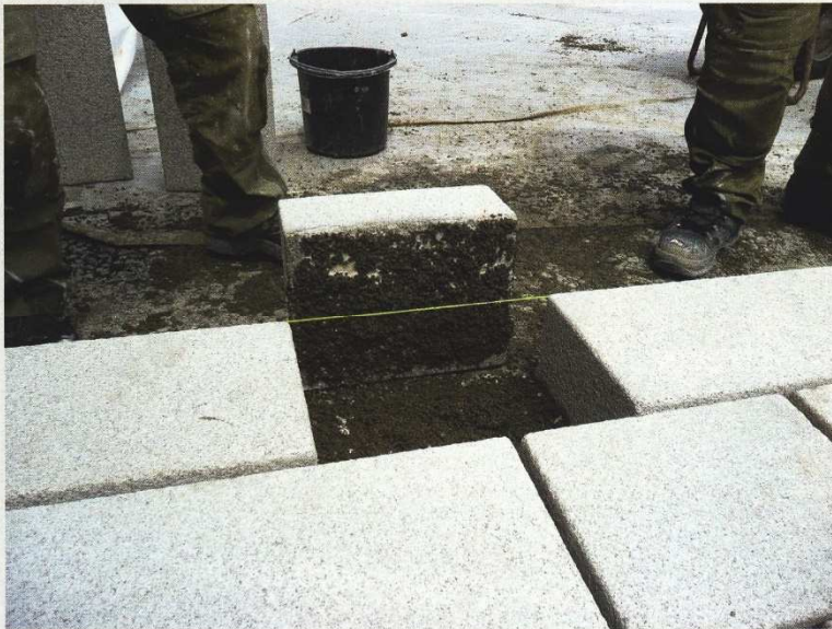
Bild 2: Haftverbund zwischen Pflasterstein und Bettung mittels Haftschlämme
