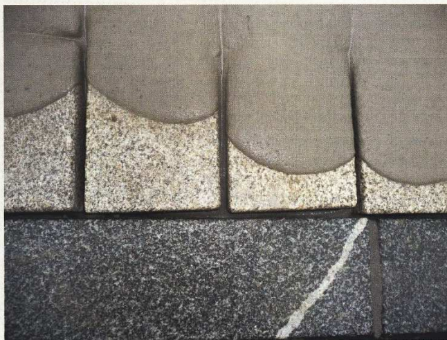
Bild 3: Konsistenz des Fugenmörtels während des Verfugens
